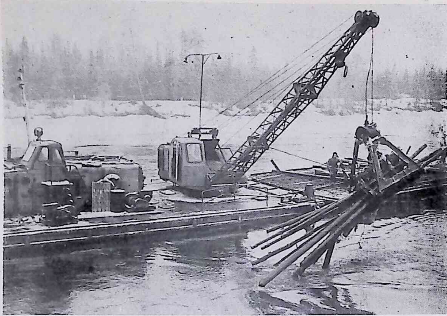
Подъем затонувшей древесины агрегатом Т-2
